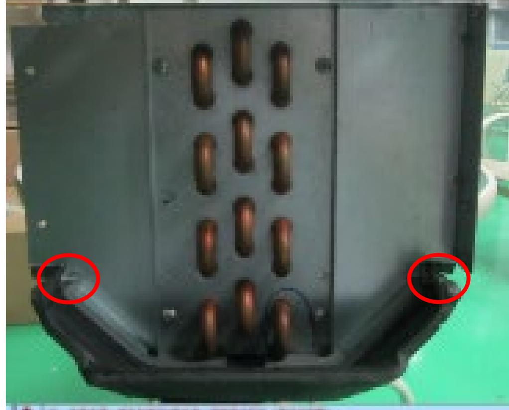
3. Снимите защитную крышку теплообменника
