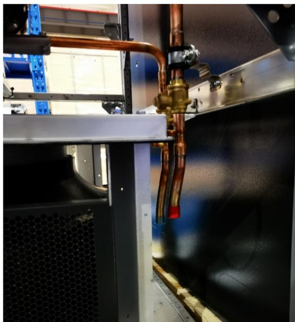
Рис. 3-38 Фото интерфейса газовой/жидкостной трубы внутреннего блока
